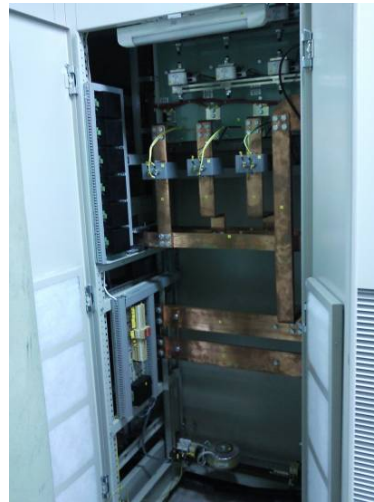
Slika 5. Tiristorski most, naizmjenični dovod i jednosmerni odvod
