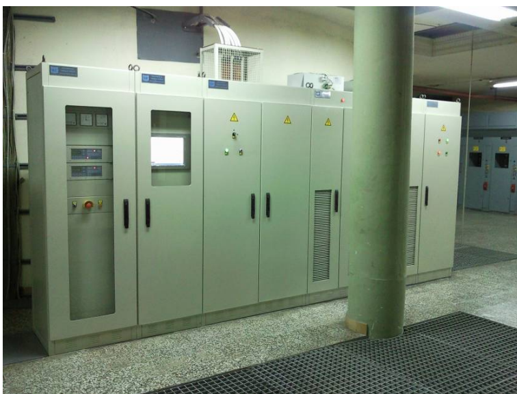
Slika 3. Sistem pobude generatora G1
