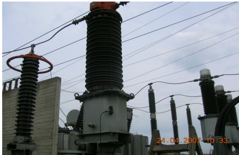
Slika 3. Postavljanje ultrazvučnih sondi na merne transformatore.
