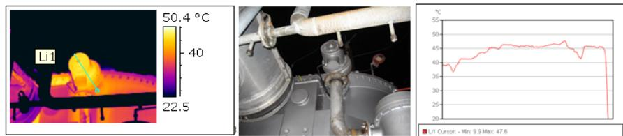
Slika broj 11 Termo- i foto slika i temperaturni profil uljne pumpe
