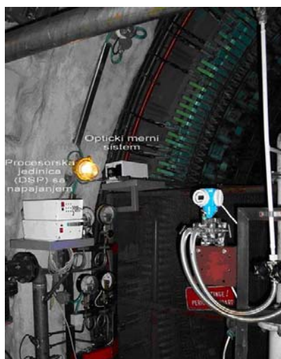
Sl. 7. Merni sistem u kapsuli hidrogenatora
