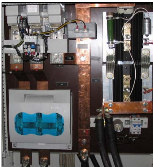
Slika 5. Energetski sklop upravljačke jedinice elektrofiltera
