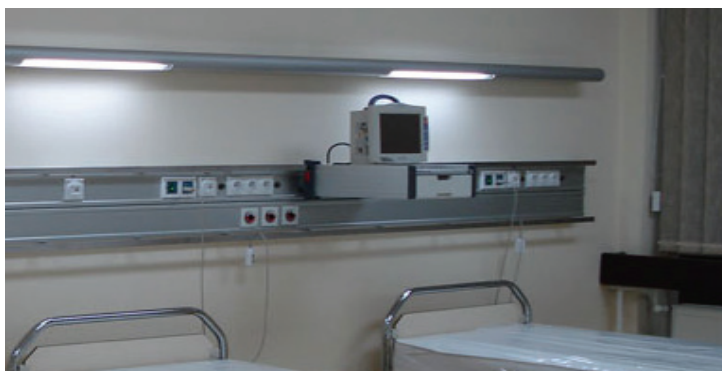
Slika 2. Izgled bolničkog parapeta sa priključcima
